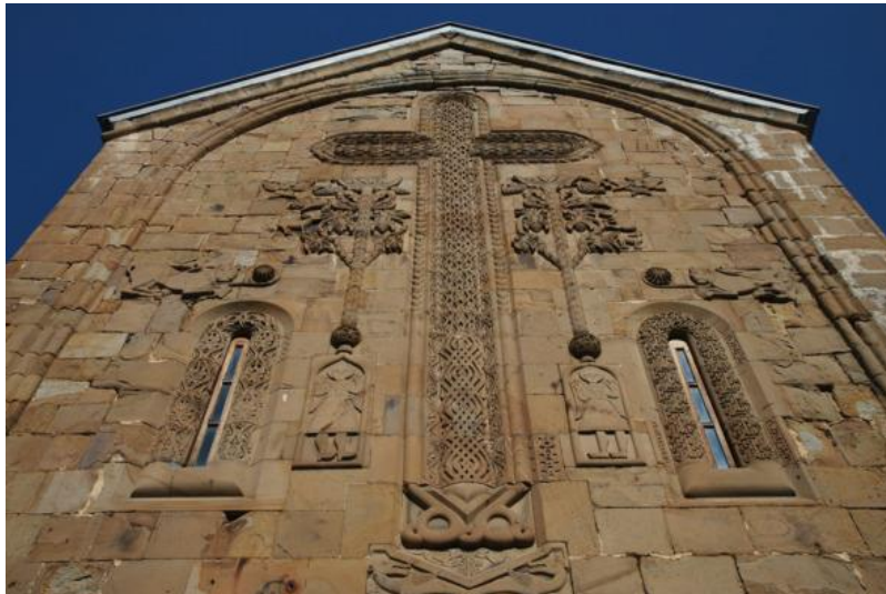
Ananuri, Fassade der Kirche Mariä Himmelfahrt
