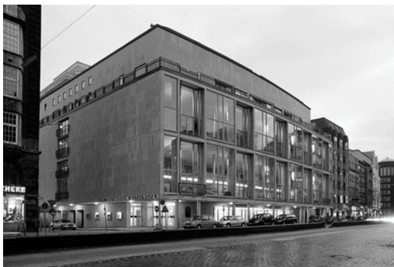
Современный вид Гамбургского театра
